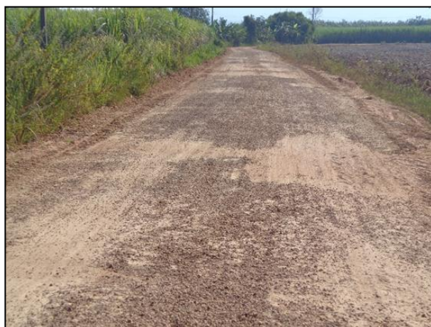
๑๓. โครงการซ่อมแซมถนนลงหินลูกรัง บริเวณเป็นหลุมเป็นบ่อ(เกลี่ยตักแต่งเรียบ) สายคำก้าว-แหล่งท่องเที่ยวด่านมันปลา และสายท่าดินแดงพัฒนา-ภูหล่น
