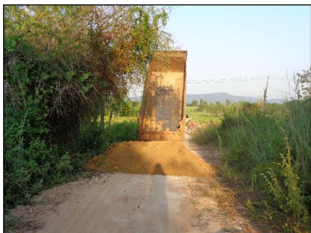
๑๓. โครงการซ่อมแซมถนนลงหินลูกรัง บริเวณเป็นหลุมเป็นบ่อ(เกลี่ยตักแต่งเรียบ) สายคำก้าว-แหล่งท่องเที่ยวด่านมันปลา และสายท่าดินแดงพัฒนา-ภูหล่น
